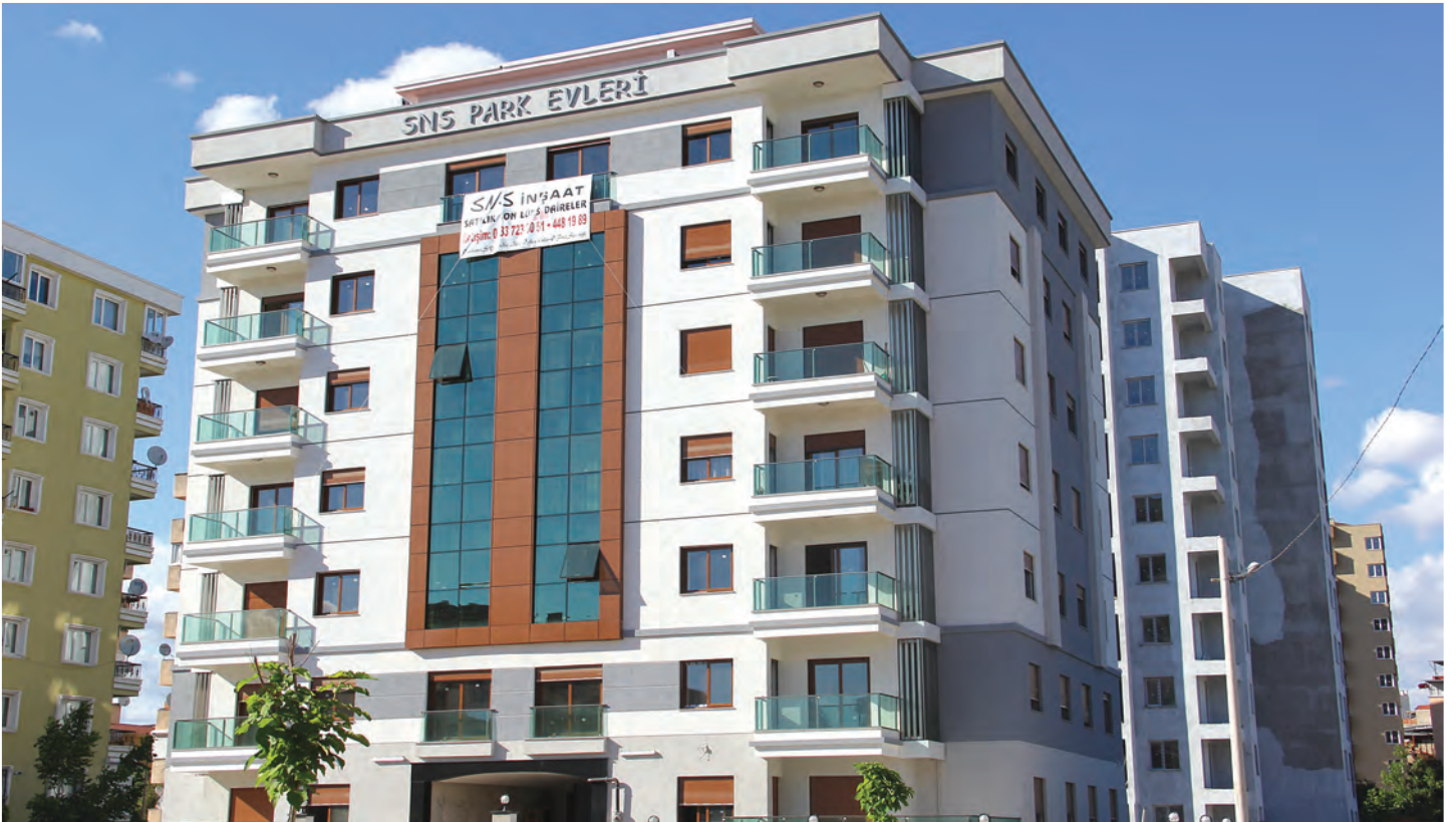
SNS İnşaat | İzmir
